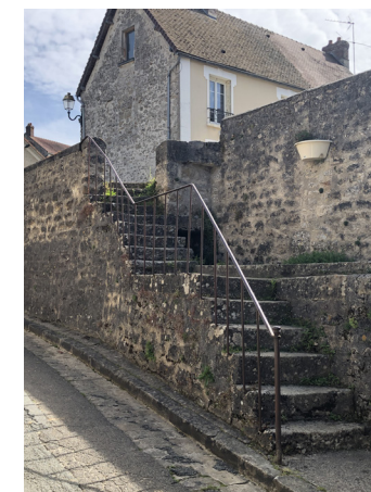
Un garde corps sur-mesure remarquable (Montalet-le-Bois).
