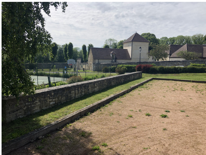
Le muret de soutènement joue également le rôle de banquette informelle pour l'aire de pétanque (Maudétour-en-Vexin).
