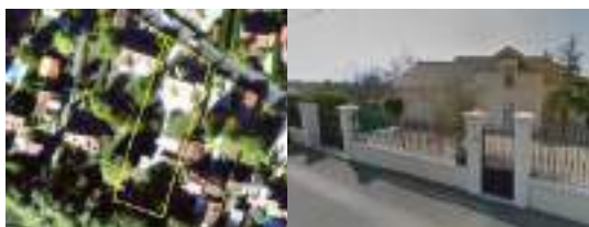
Opération de démolition-reconstruction d'un logement individuel pour la construction d'un nouveau pavillon (rue des Gords, Auvers-sur-Oise, 2009)
