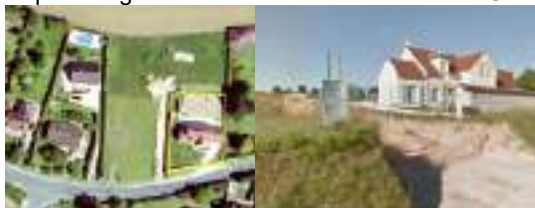
Construction d'un logement individuel dans le cadre d'un lotissement créé sur une parcelle agricole (rue de la Libération, Chars, 2015)
