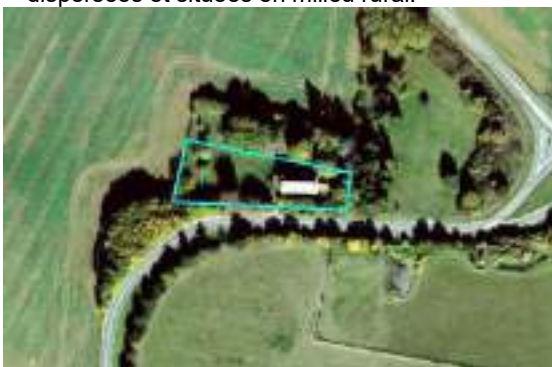
Ancien corps de ferme réhabilité en maison individuelle sur Omerville
