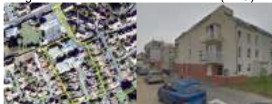
Opération de démolition-reconstruction de 6 logements individuels pour la création de 32 logements collectifs (rue Pablo Picasso, Persan – hors territoires, 2010)
