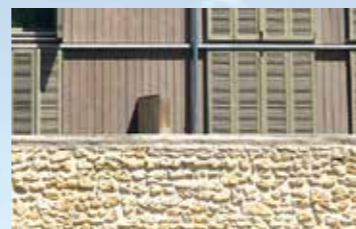
Marines : 12 logements Architectes : Atelier15 - Patrick Bertrand A Marines, un muret vient rappeler la tradition des murs du Vexin pour clôturer une opération de logements dont l'écriture contemporaine est affirmée.
