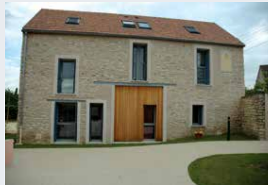
Réhabilitation d'une ferme à Follainville 6 logements Maître d'Ouvrage : Mantes en Yvelines Habitat (MYH) architectes H=L ARCHITECTURE
