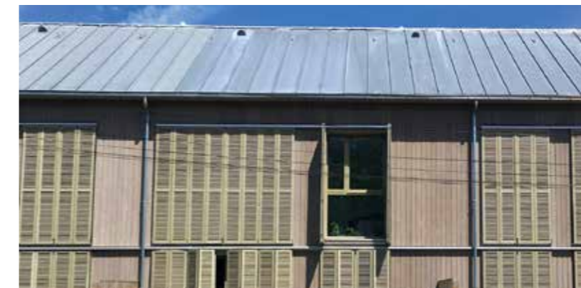
Marines :12 logements Architectes : Atelier15 - Patrick Bertrand Sur cet exemple de logements à Marines, le bois est posé verticalement et grisé pour mieux maîtriser son vieillissement.
