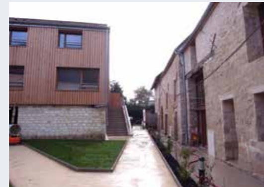
Réhabilitation d'une ferme à Auvers sur Oise : 15 Logements Maître d'Ouvrage : 3F Immobilière Architecte : Agence EQUATEUR
