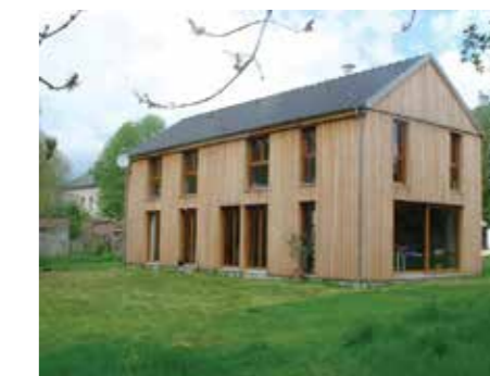
Maison à Guitrancourt - Ossature bois bardage bois à posé verticale. Architecte : Flavie Demagny
