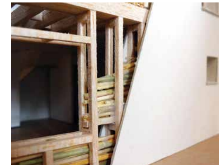
Exemple en maquette d'une construction à ossature bois et isolée avec de la paille.
