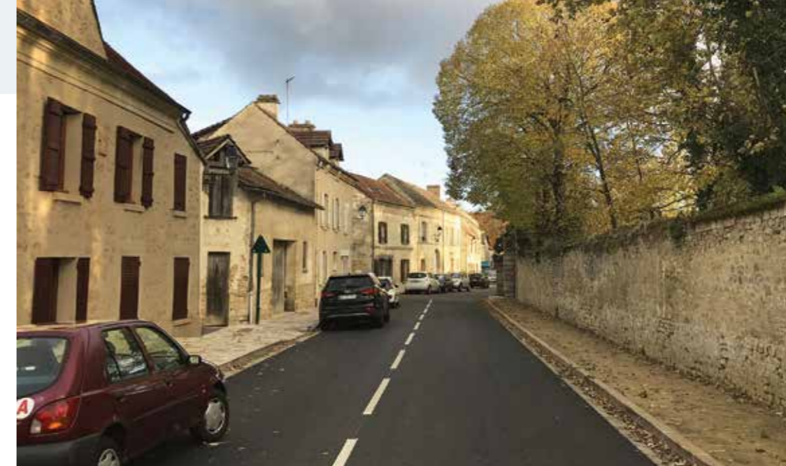
Vigny - Le bâtiment existant est une remise agricole typique du petit patrimoine rural, implantée à l'alignement de la rue face au parc du Château.
