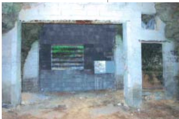
Villarceaux : entrée de cavité (vue interne)
