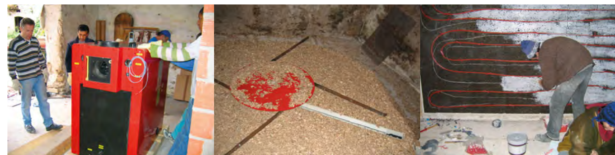
Installation de la chaudière à bois (fonctionnant grâce aux déchets d'élagage) et d'un mur chauffant.
