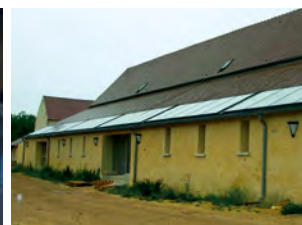
Panneaux solaires à la Bergerie de Villarceaux
